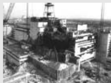
l'esplosione distrusse tutte le parti in muratura del reattore e liberò nell'aria tonnellate di materiali radioattivi, in gran parte residui di combustione atomica
